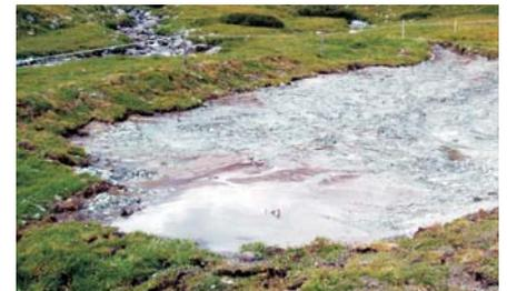
Eine Fläche von rund 220 Quadratmeter des früheren Flachmoores wird nach dem Abtrag der Grasnarbe aufgestaut und mit geeignetem Tonmaterial abgedichtet.
