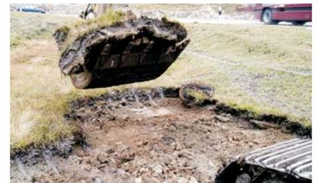
Beim vom Strassenbau beeinträchtigten Flachmoor wird der Soden mit der Baggerschaufel sorgfältig abgeschält.
