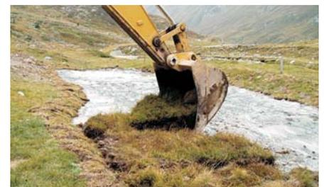
Der abgeschälte Flachmoorsoden wird am neuen Standort auf den künstlich angelegten Tonboden verlegt.
