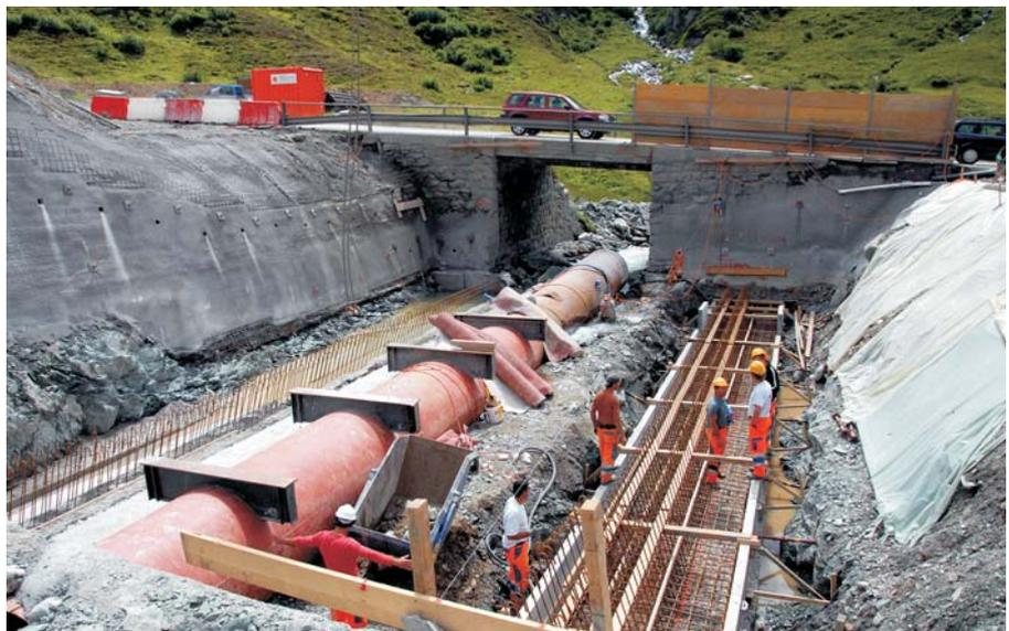
Der Durchlass Suracqua im Bau, in der Mitte die provisorische Bachführung im Rohr
