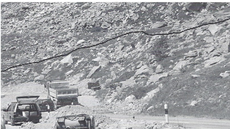
Abbildung 2 Dank Direktanlage von Bodenmaterial, Rasensoden und Blöcken ist die weit zurückversetzte neue Böschung kaum erkennbar (unterhalb der roten Linie). Foto © Tiefbauamt Graubünden
