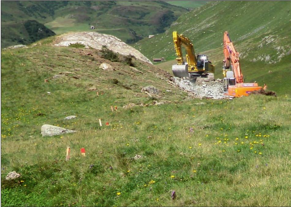
Abb. 6: Vorne Borstgrasrasen-ähnlicher Lebensraum, hinten abgesenkte mit Direktumlagerung erstellte neue Böschung
