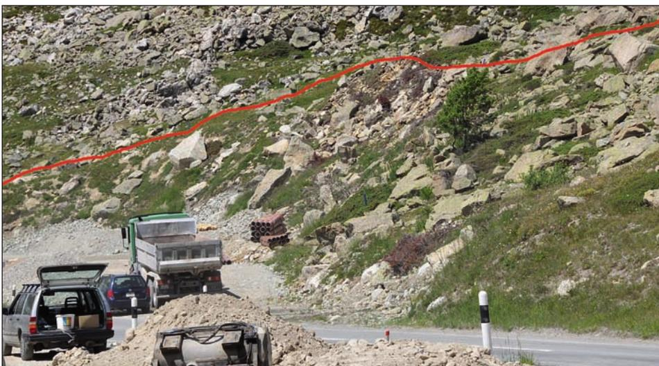
Abb. 12: Blockreiches Gelände neu angelegt (unterhalb der roten Linie). Optimale Einpassung in die Landschaft
