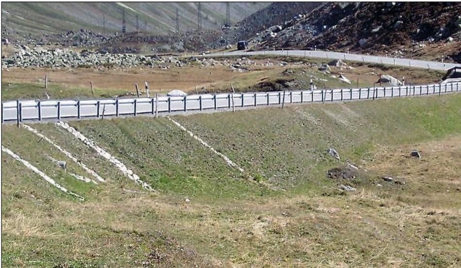
Abb. 10: Konventionelle, geometrisch angelegte und angesäte Strassenböschung
