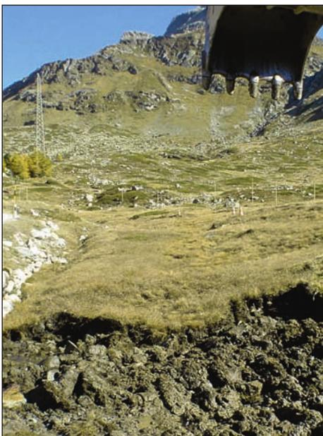
Abb. 3: Flachmoorsoden – Abtrag aus einer vom Strassenbau beanspruchten Fläche für die Direktumlagerung
