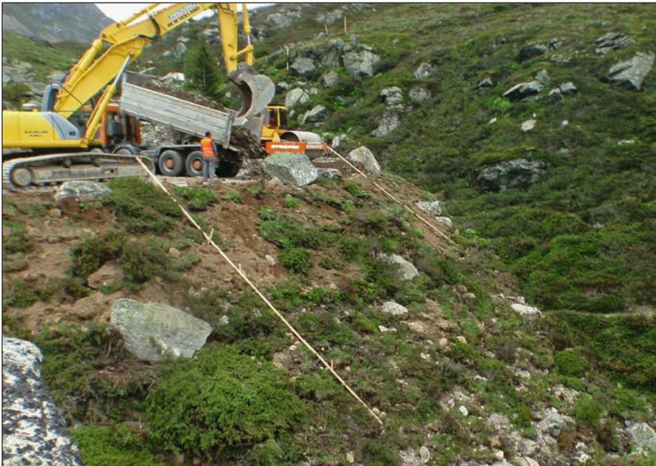
Abb. 7: Bau einer neuen Schüttung: Borstgrasrasen und Zwergsträucher werden direkt umgelagert, ohne weitere ingenieurblogische Verbauungen.
