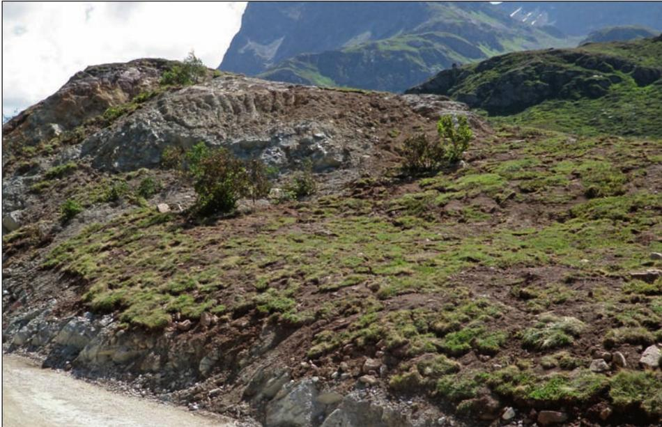
Abb. 13: Frisch mit Direktumlagerung angelegte sanfte Böschung mit belassenem Felsen, landschaftlich angepasst
