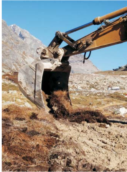
Abtrag und Einbau eines Flachmoores sowie Blick auf fertig erstelltes Flachmoor (Bildmitte) in neuer Gelgia-Aufweitung.
