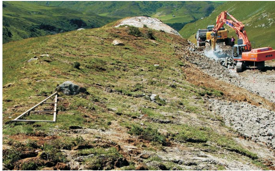
Mit Direktumlagerung von Boden und Rasenziegeln neu erstellte angepasste Böschung mit belassener Felskuppe.
