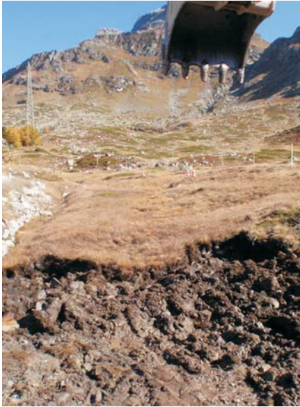
Abtrag und Einbau eines Flachmoores sowie Blick auf fertig erstelltes Flachmoor (Bildmitte) in neuer Gelgia-Aufweitung.
