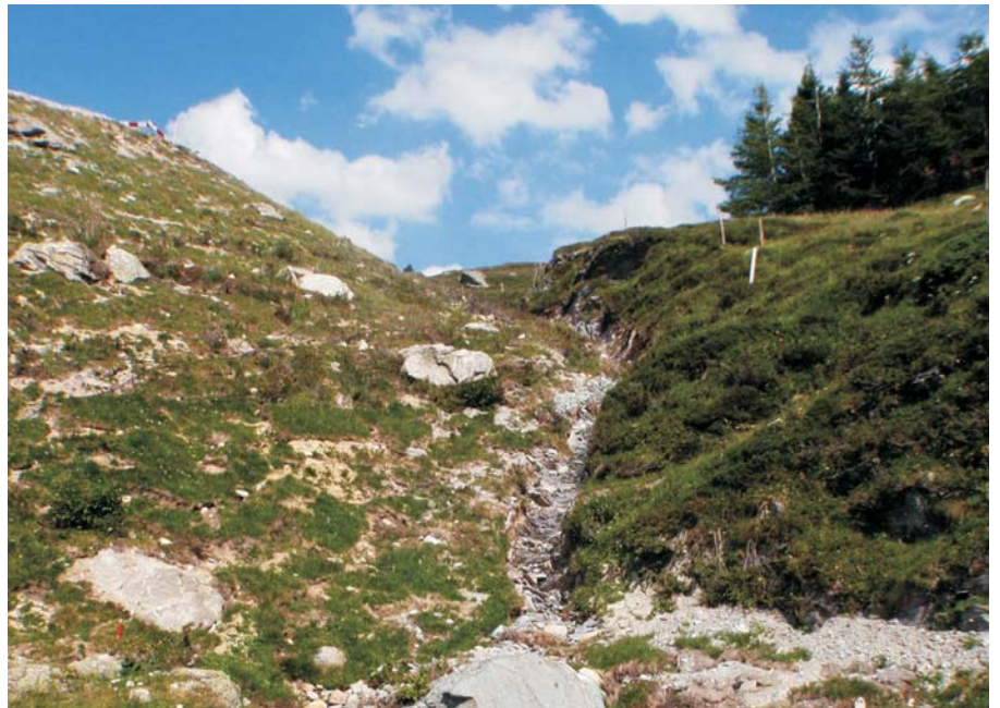
Links im Bild eine mit Direktumlagerung neu geschüttete Böschung und neu erstelltem Bachlauf, rechts das gewachsene Terrain.
