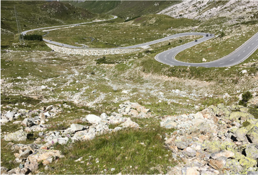
Nach den Strassenbauarbeiten am Julierpass wurde die Morphologie des Geländes rekonstruiert und mit unterschiedlichen Begrünungsmethoden renaturiert. Bild: Tiefbauamt Graubünden, Plan: ewp/ Nina von Albertini
