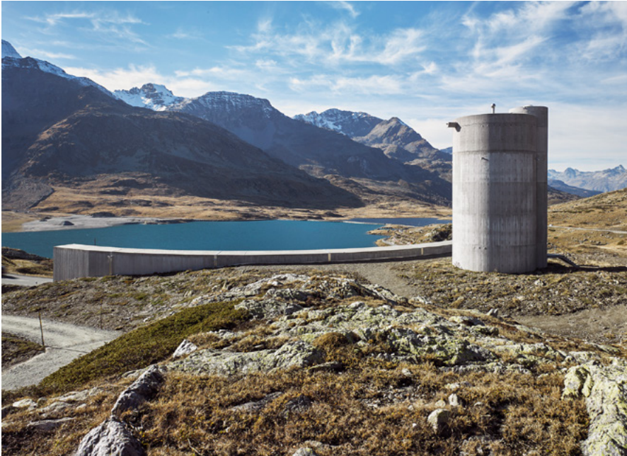
Einpassung in die Landschaft und rekonstruierte Natur auf dem Dach des Unterhaltsstützpunkts am Berninapass. Bild: Guido Baselgia, Plan: Bearth Deplazes Ladner Architekten
