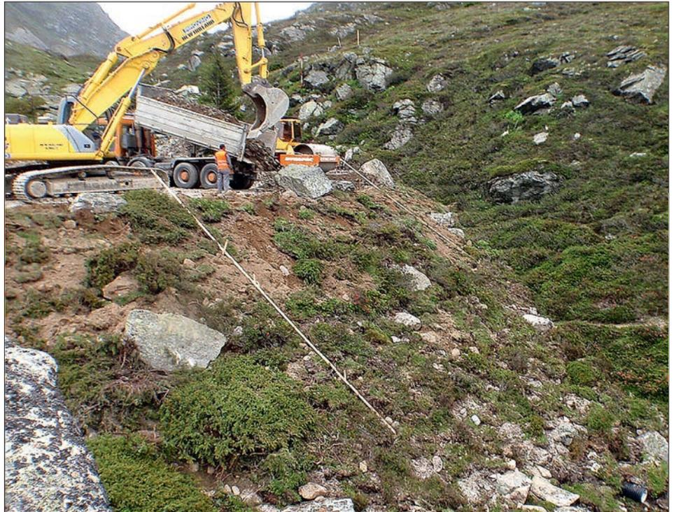
Abb. 1: Direktumlagerung im Untersuchungsgebiet: Vegetationsziegel werden ohne weitere ingenieurbiologische Massnahmen (z.B. Befestigung mit Holznägeln) direkt und stabil zwischen die fest in den Boden eingelagerten Blockschuttfelsen eingebracht (von Albertini 2014).
