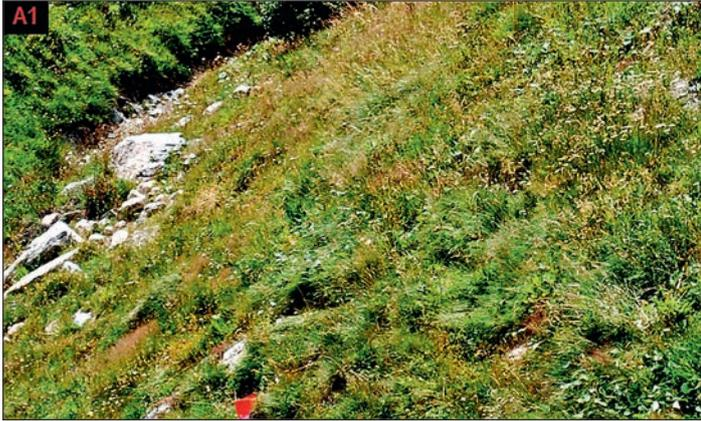
Abb. 10: Die durchschnittlich 45° steile Böschung der Untersuchungsfläche A1 weist einen hohen Vegetationsdeckungsgrad auf. Die Lücken zwischen den Ziegeln sind nur noch schwer erkennbar. Die gewollt naturnahe Gestaltung der Begrünung mit kleinräumig unebener Struktur ist gut erkennbar.
