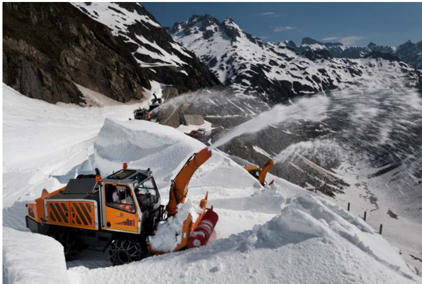
An der unteren Wendeplatte am Ober Susten müssen sich die Maschinen im Juni 2019 durch eine achtzehn Meter hohe Schneewand fräsen.
