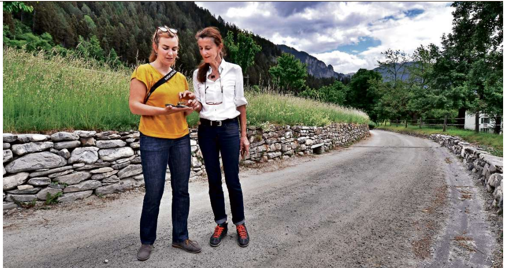
Natursteinmauern und Schotterbelag statt Normstrasse mit Asphalt: Jacqueline von Arx (links) und Nina von Albertini auf der sanierten Duscherstrasse.
